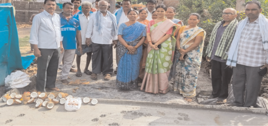
తొలి సమయం,ఇల్లందు;జూన్, 30: ఇల్లందు మండలంలోని సుదిమల్ల గ్రామపంచాయతీ పరిధిలోని కొత్తూరు గ్రామంలో రూ.10 లక్షల వ్యయంతో చేపట్టనున్న సీసీ రోడ్డు నిర్మాణ పనులకు గ్రామ సర్పంచ్ కుంజా సుకనయ్య శంకుస్థాపన చేసి పనులను ప్రారంభించారు.ఈ సందర్భంగా సర్పంచ్ మాట్లాడుతూ గ్రామాభివృద్ధికి ప్రాధాన్యత ఇస్తూ మౌలిక వసతుల కల్పనపై ప్రత్యేక దృష్టి సారిస్తున్నామని తెలిపారు. సీసీ రోడ్డు నిర్మాణాన్ని నాణ్యత ప్రమాణాలకు అనుగుణంగా చేపట్టాలని కాంట్రాక్టర్‌కు సూచించారు. గ్రామపంచాయతీ పరిధిలో పలు అభివృద్ధి పనులు కొనసాగుతున్నాయని, ఇందిరమ్మ గృహాల నిర్మాణంలో భాగంగా స్టాల్ పనులు కూడా వేగంగా జరుగుతున్నాయని పేర్కొన్నారు.ఈ కార్యక్రమంలో ఉపసర్పంచ్ ఊకే లక్ష్మీనారాయణ, వార్డు సభ్యులు ఎర్రయ్య, ఊకే భద్రమ్మ, సూర్య పాక రమేష్, కల్లి పద్మ, గ్రామ పెద్దలు ఊకే అబ్బయ్య, చీమల బక్కయ్య, ఊకే ఎర్రయ్య, ఊకే బుచ్చయ్య తదితరులు పాల్గొన్నారు.
